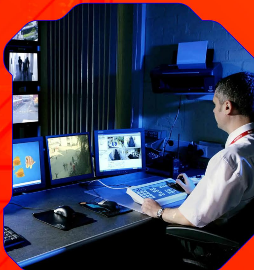
SISTEMAS DE SEGURIDAD
